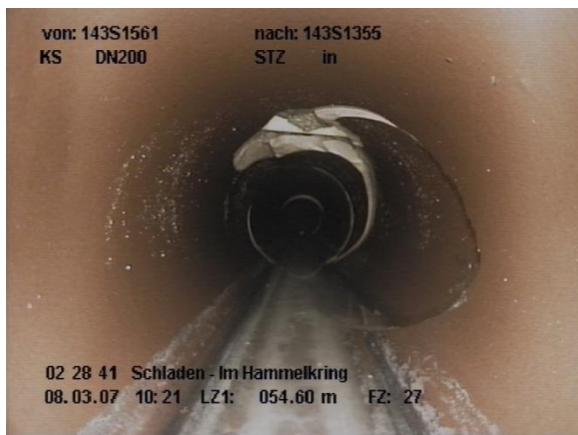
Scherbenbildung und Leitungseinbruch
