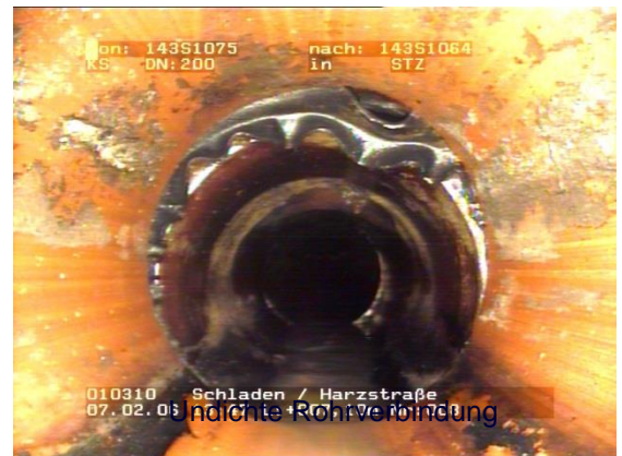
Undichte Rohrverbindung
