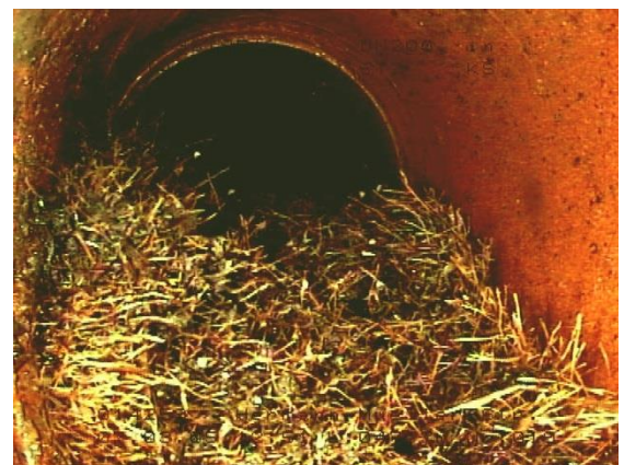
Wurzeleinwuchs in den Kanal
