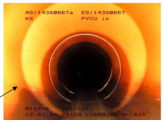
Wurzeleinwuchs in den Kanal
